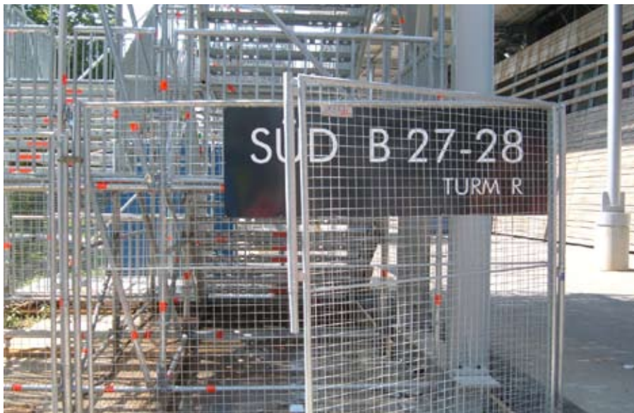
Auch die Treppentürme des Salzburger Stadions wurden abgesichert.
